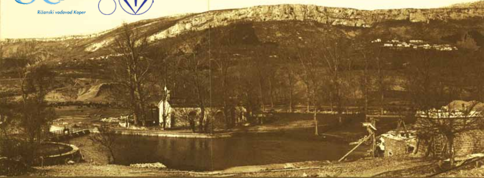
▲ VEDUTA GENERALE DELLE OPERE NELLA ZONA DELLE SORGENTI DI S. MARIA DEL RISANO ▲
