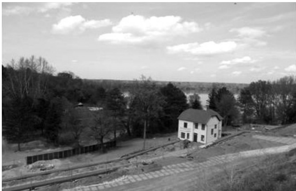
Pogled na Villu Streim i gornji dio Muzeja Vučedol u izgradnji. (Izvor: Dina Pervan, 2012.)
